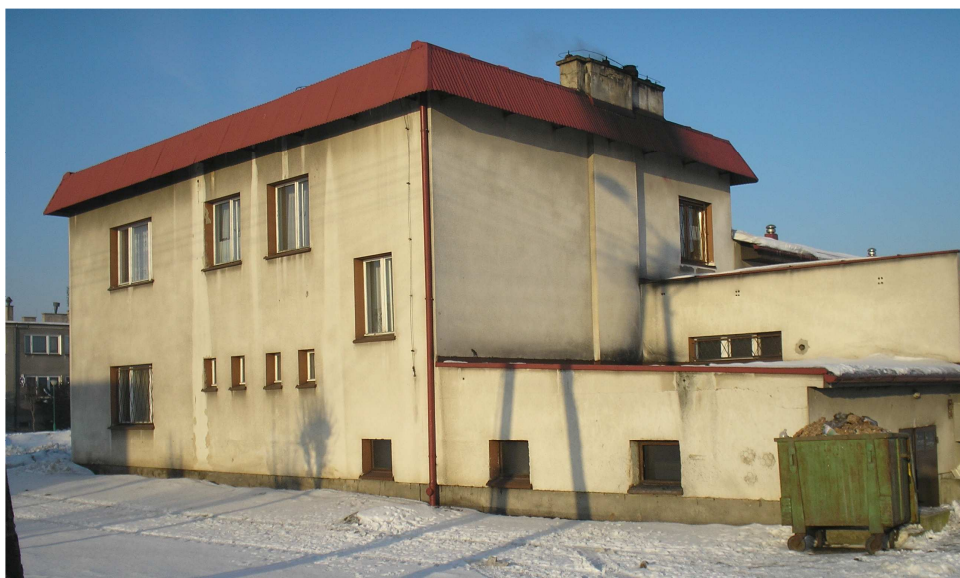
Rysunek 9.2. Budynek sali wiejskiej – widok od ul. Dojazdowej
