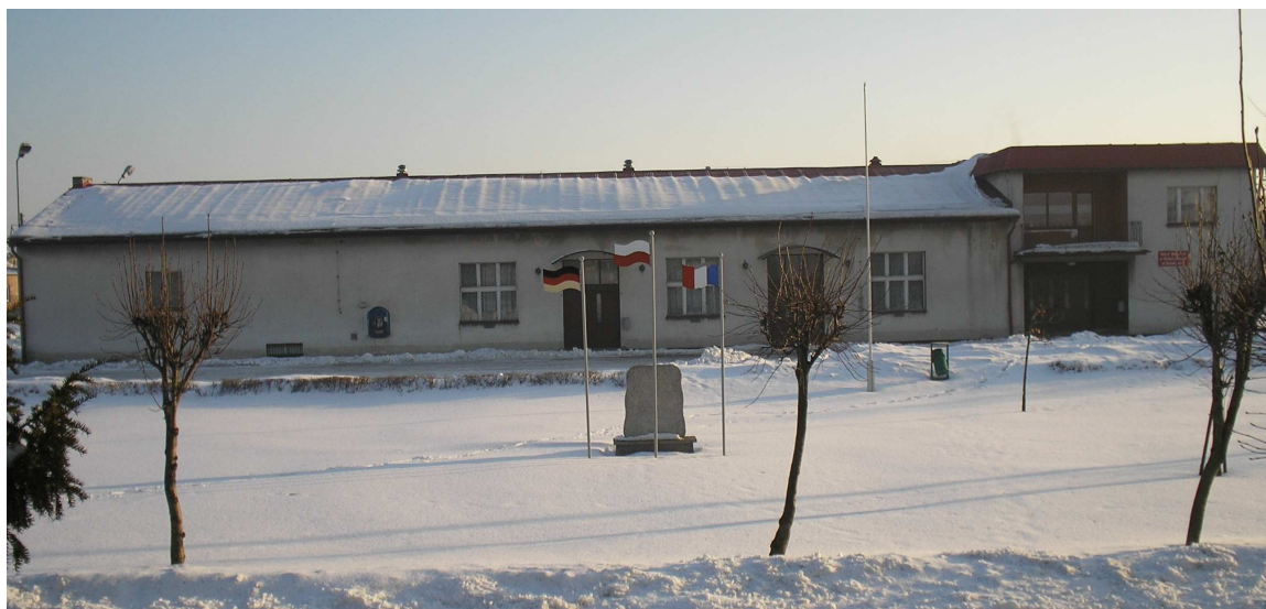
Rysunek 9.1. Budynek sali wiejskiej – widok od frontu
